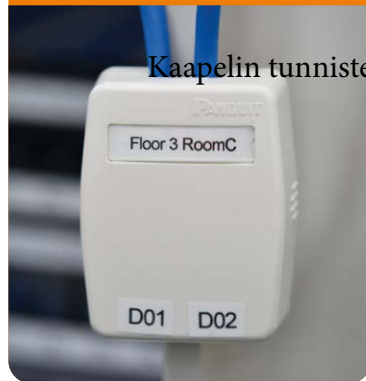
Laite- ja puhelinpistokkeet
