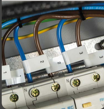
Johtojen ja kaapelien merkitseminen
